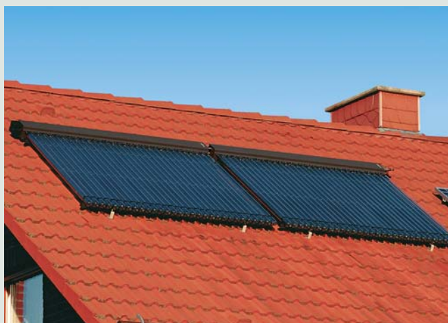
Colector solar alcătuit din tuburi vidate cu funcționare pe principiul Heatpipe
